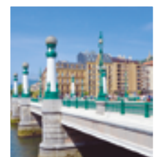
Puente de la Zurriola, San Sebastián
